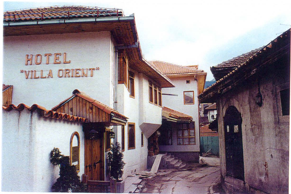
Bespravna izgradnja na Baš-čaršiji (veza ulica Bravadžiluk i Telali)
