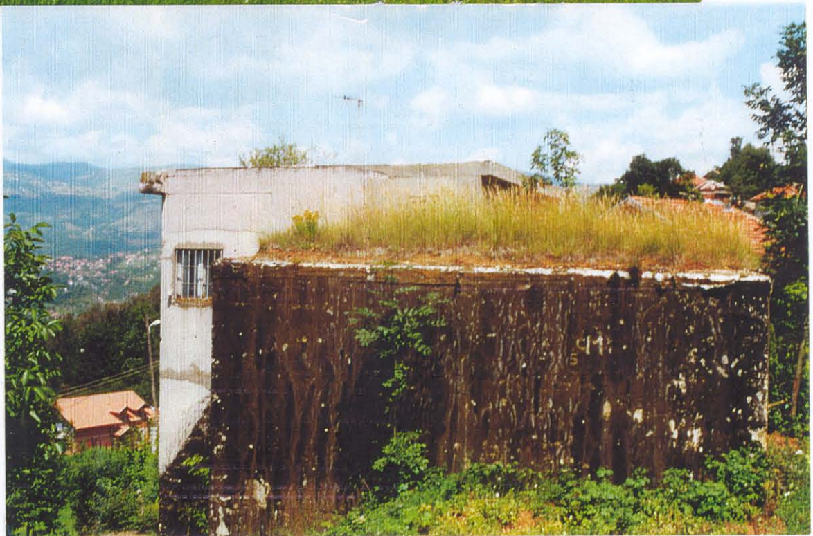
Devastirani objekti vodovoda Hrid
