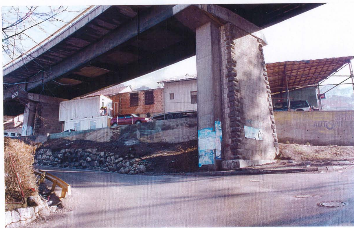
Uz staru željezničku stanicu na Bistriku postavljen je betonski montažni kiosk sa pogledom na Grad, a ispred i oko Bistričkog mosta izgrađeni su bespravni objekti koji ugrožavaju i sam most
