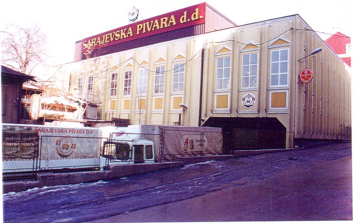
Bespravno izgrađena hala sarajevske Pivare
